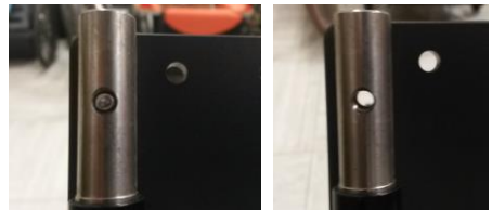
Abbildung 4 – Entfernen der Schrauben der Sitz- und Rückfläche
